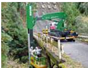
▲橋梁の定期点検
