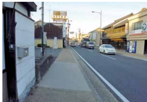
国道369号(奈良市押上町) <整備後>
