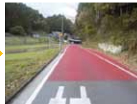
薄層舗装などの注意喚起 により安全性が向上
