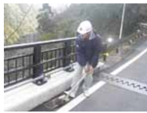
▲集水樹の清掃を実施
