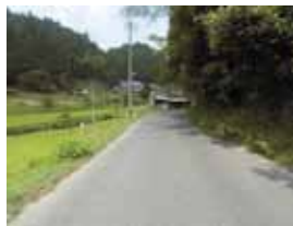
見通しの悪いカーブでの 正面衝突事故多発
